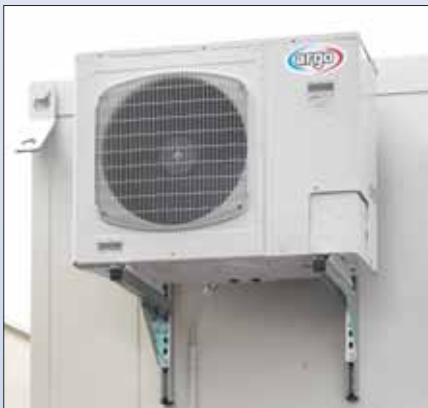
Equipo de refrigeración tipo split (vista exterior)
