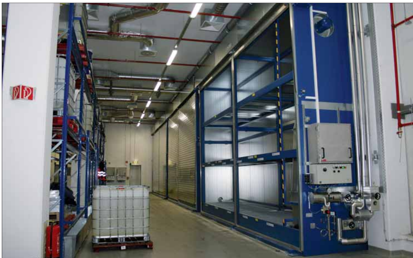
Cámara de calentamiento WK 714-3 con 3 niveles de almacenamiento y persiana. Calentamiento de potenciadores de sabor hasta 50 °C en la industria alimentaria. Revestimiento interior galvanizado. Protección contra explosiones (ATEX) interior y exterior. Calefacción de vapor.
