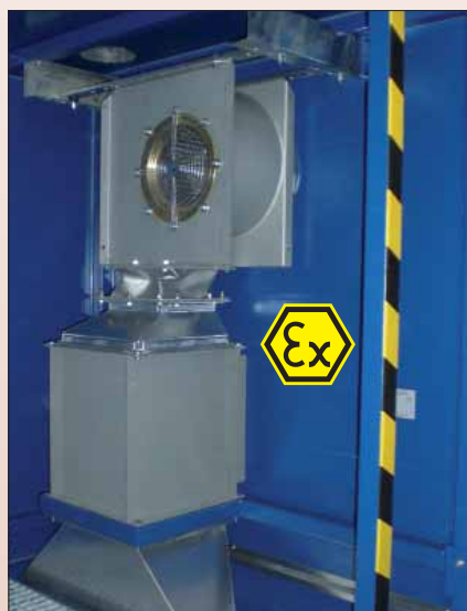
Unidad interior de la calefacción con ventilador de convección, canal de conducción del aire y protección contra explosiones / ATEX.
