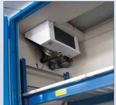
Equipo de refrigeración tipo split (vista interior) en versión ATEX para almacenamiento / tratamiento de sustancias inflamables.
