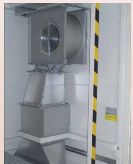
Unidad interior de la calefacción con ventilador de convección, canal de conducción del aire, sin protección contra explosiones.
