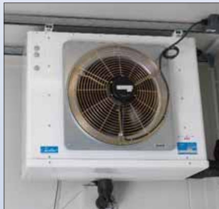
Equipo de refrigeración tipo split (vista interior)
